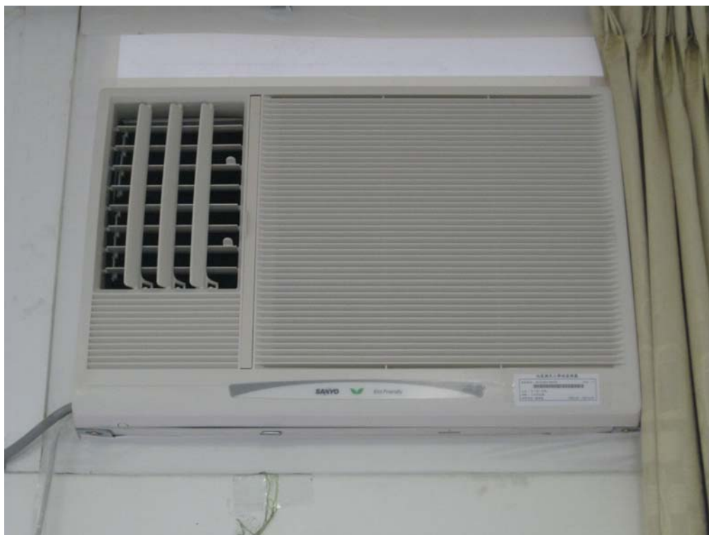
照片說明：冷暖氣機安裝完成。
