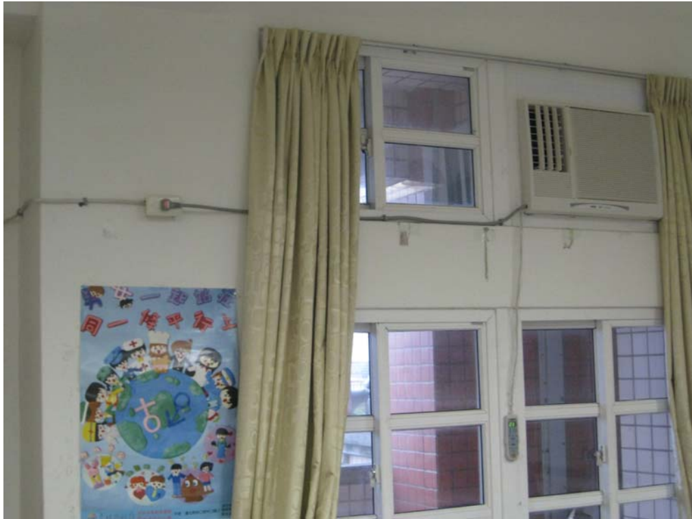
照片說明：冷氣機電源線路安裝完成。
