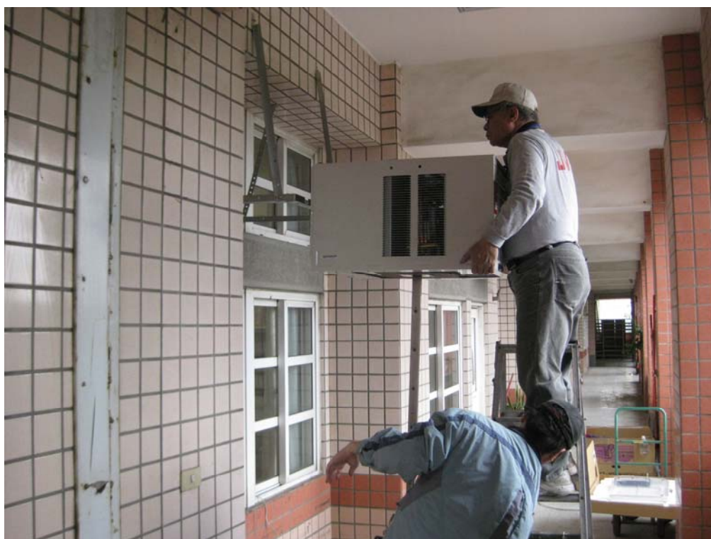
照片說明：利用升降機安裝冷氣機。
