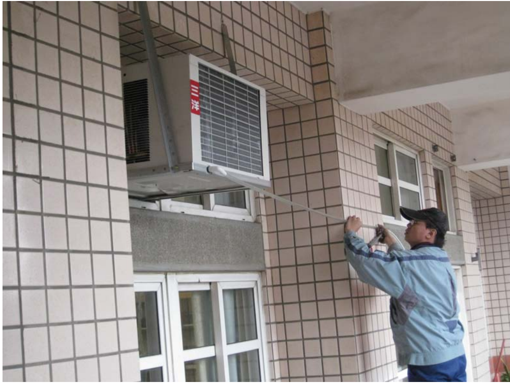
照片說明：安裝冷氣機排水管線。
