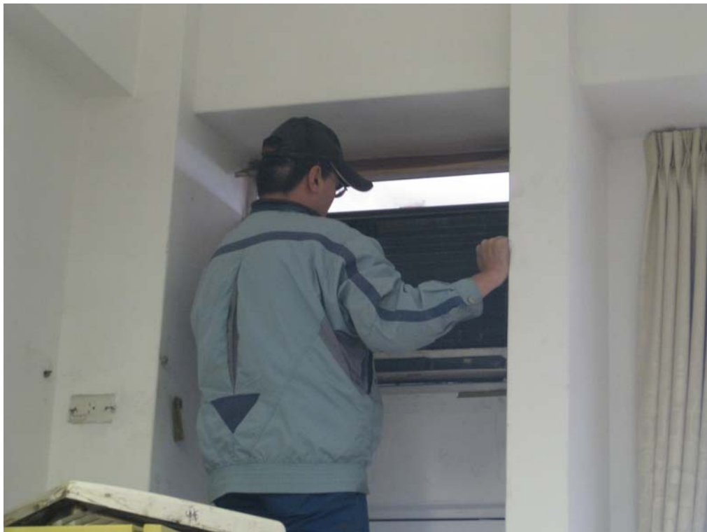
照片說明：拆卸舊冷氣機。
