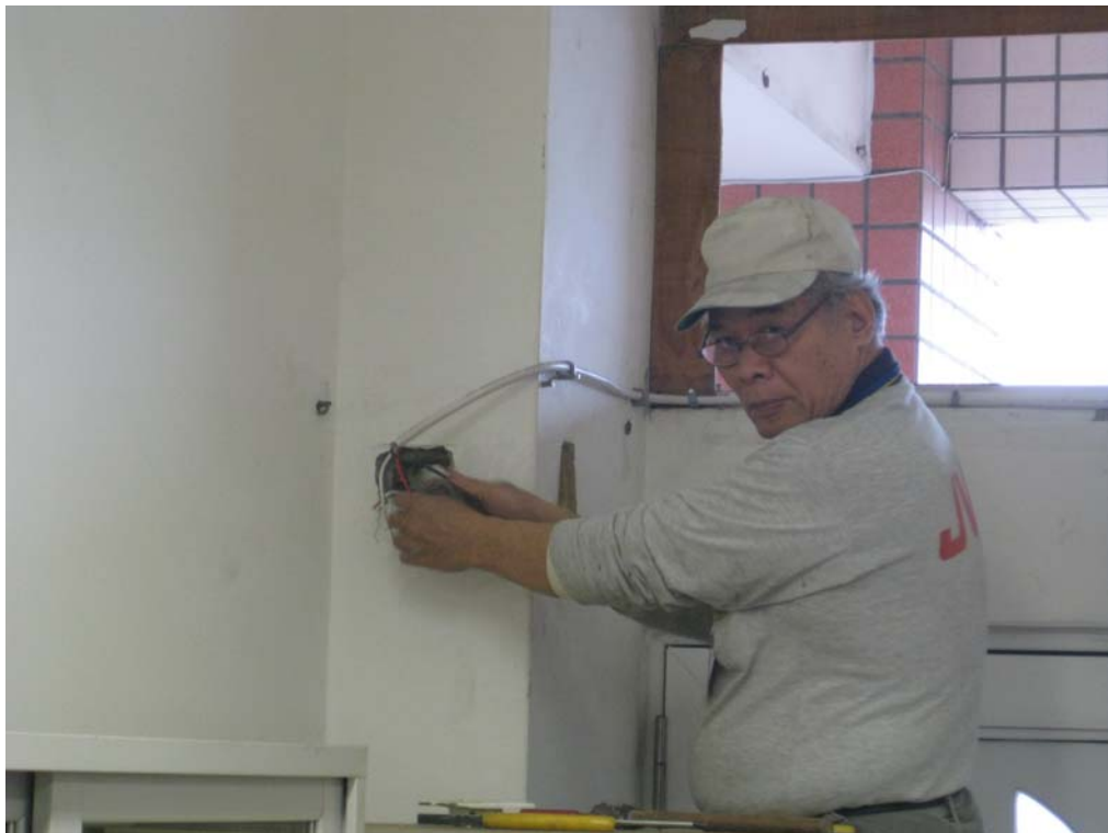
照片說明：安裝 220 伏特冷氣機電源。
