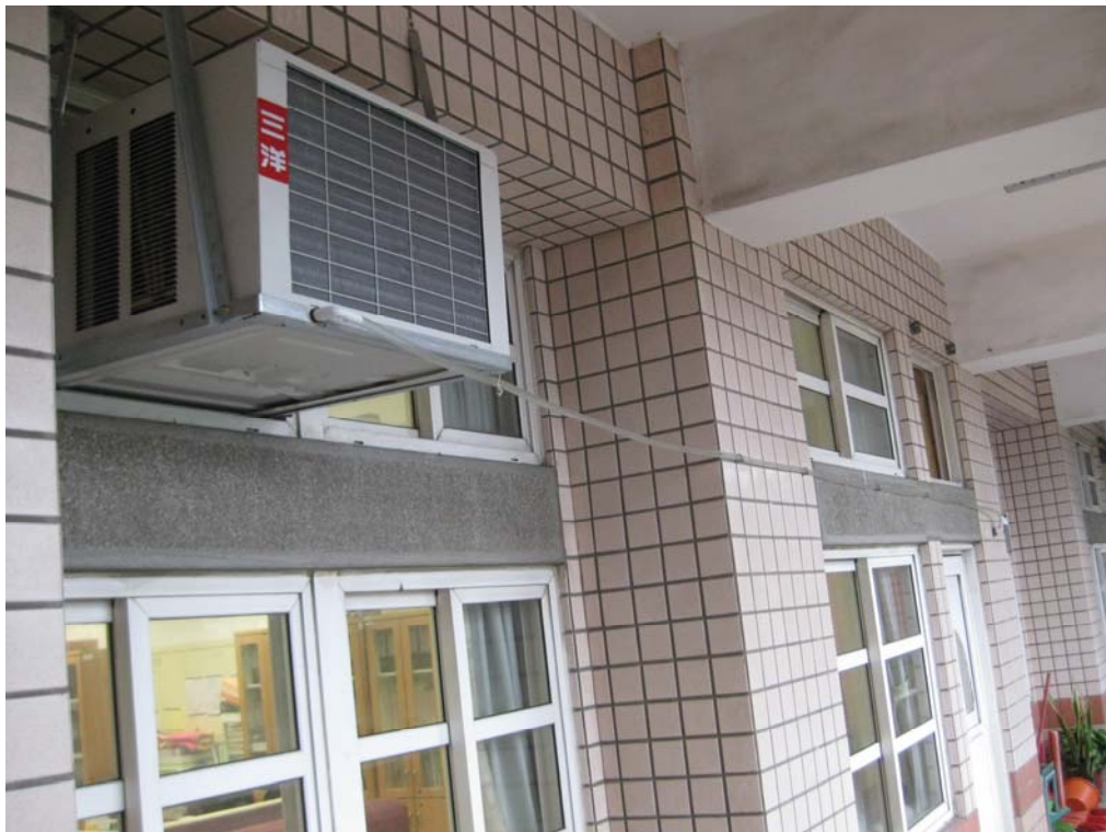
照片說明：冷氣機完成排水線路安裝。
