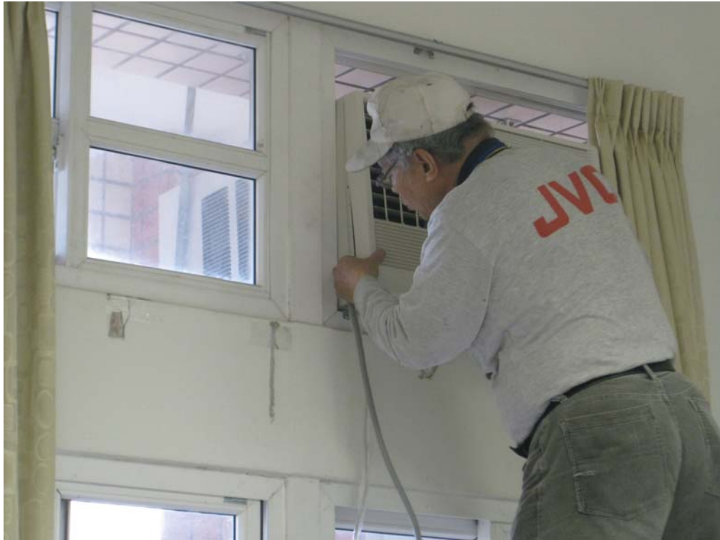
照片說明：安裝冷氣機面板。
