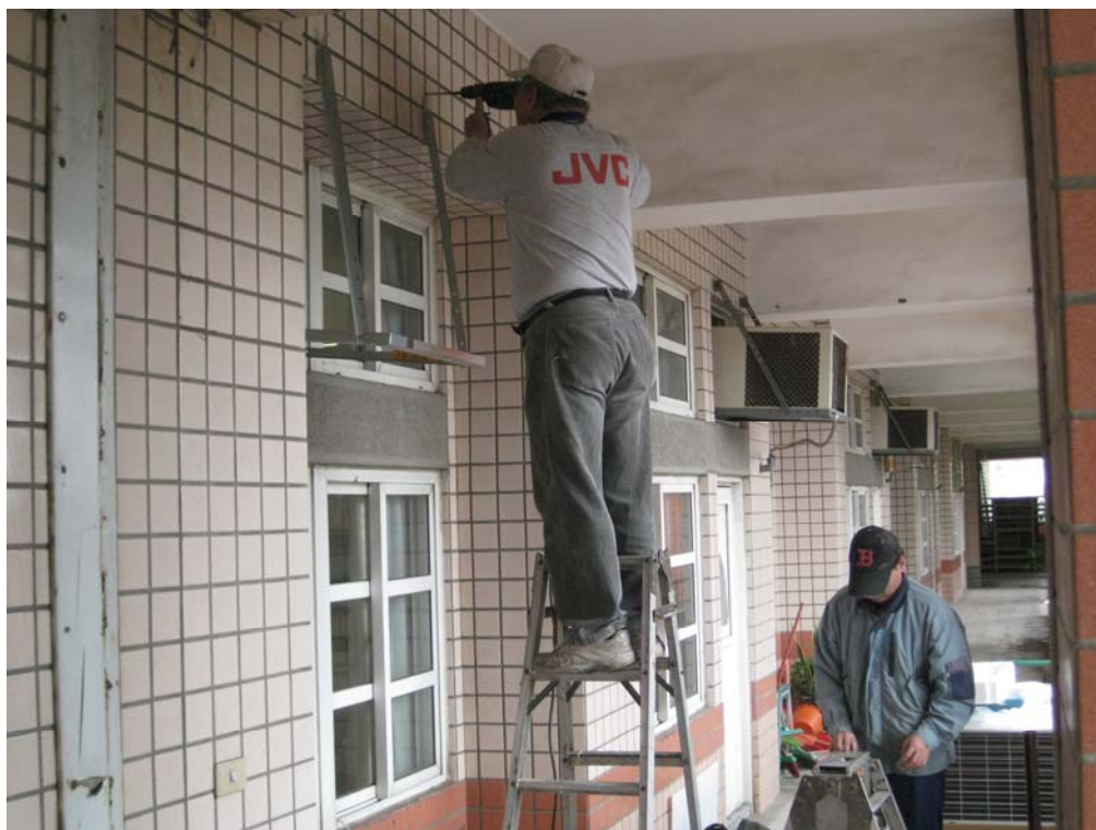
照片說明：安裝冷氣機支撐架。
