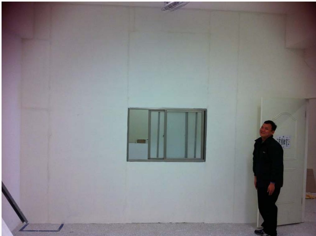
照片說明：教室內牆面。
