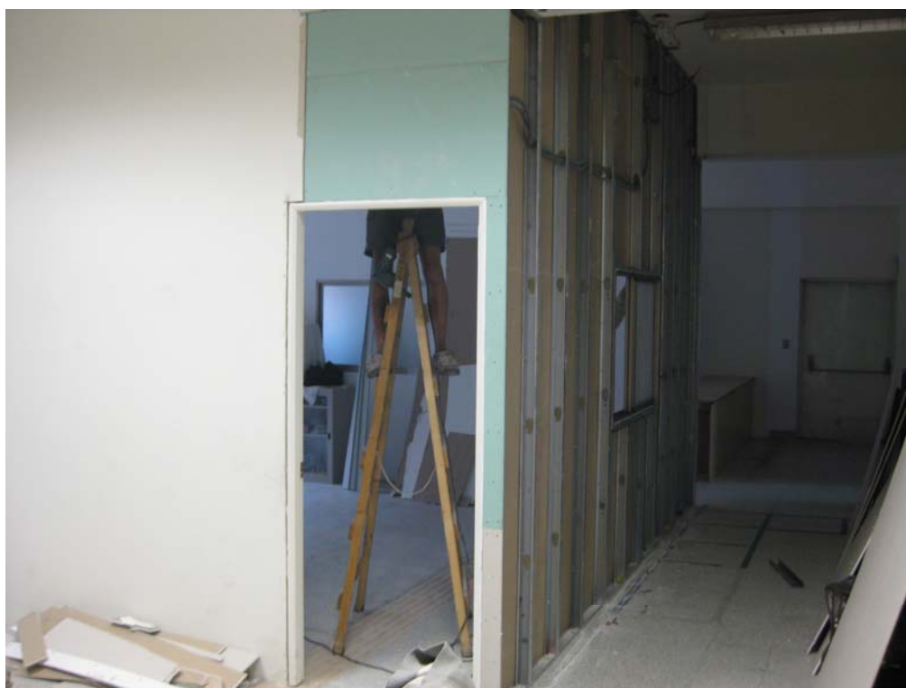
照片說明：拆除距離不合格之牆面及鋼架。
