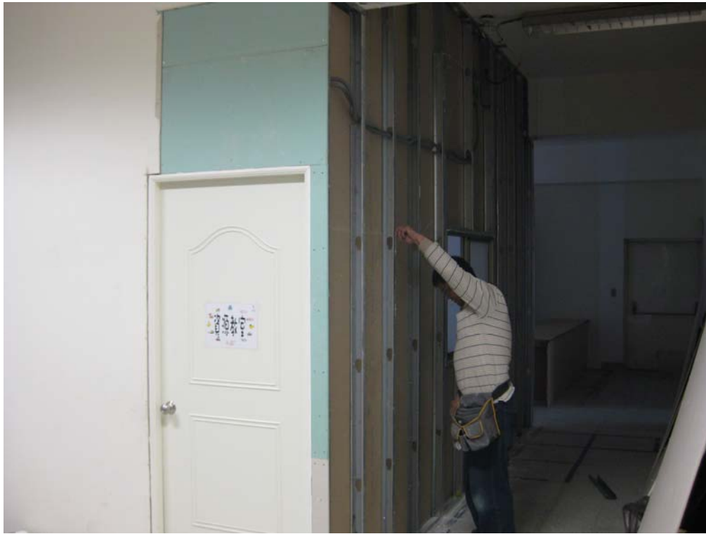
照片說明：拆除距離不合格之牆面及鋼架。
