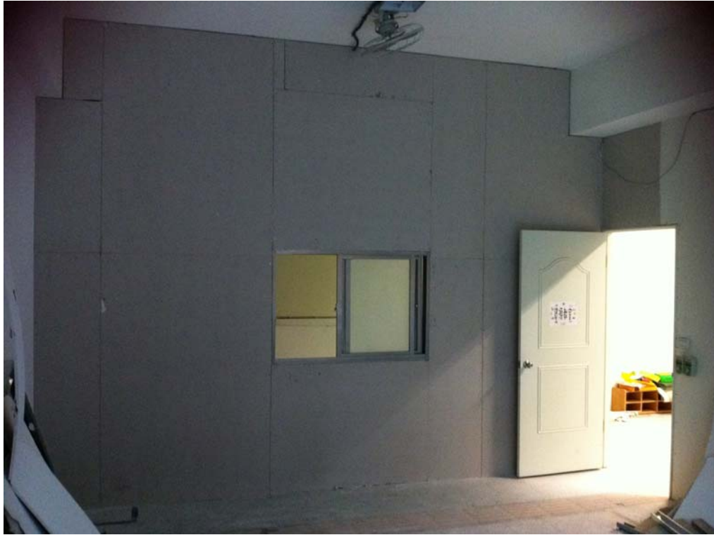
照片說明：教室內牆面。
