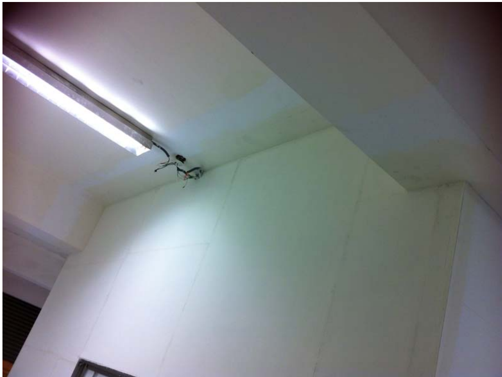
照片說明：電燈及天花板復原。
